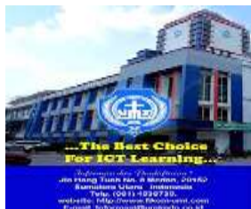
Gambar 3.2 : Gedung Universitas Methodist Indonesia 1 Medan
